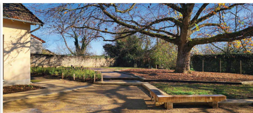
Après les travaux
