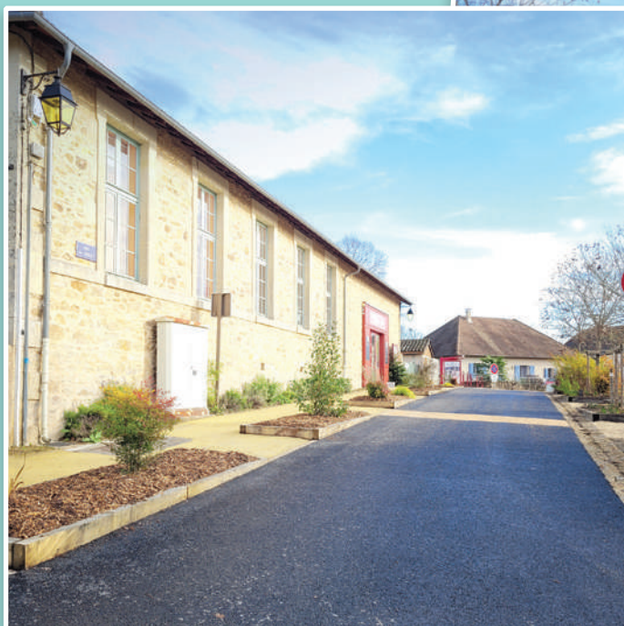
Après les travaux
